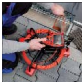
Обследование ливневых труб
